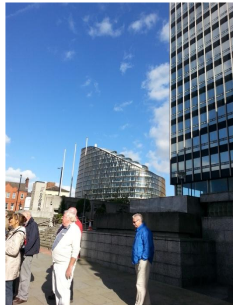
Twee gebouwen Coöperative. Rechts de curtainwall en in verte met voorzetgevel.
