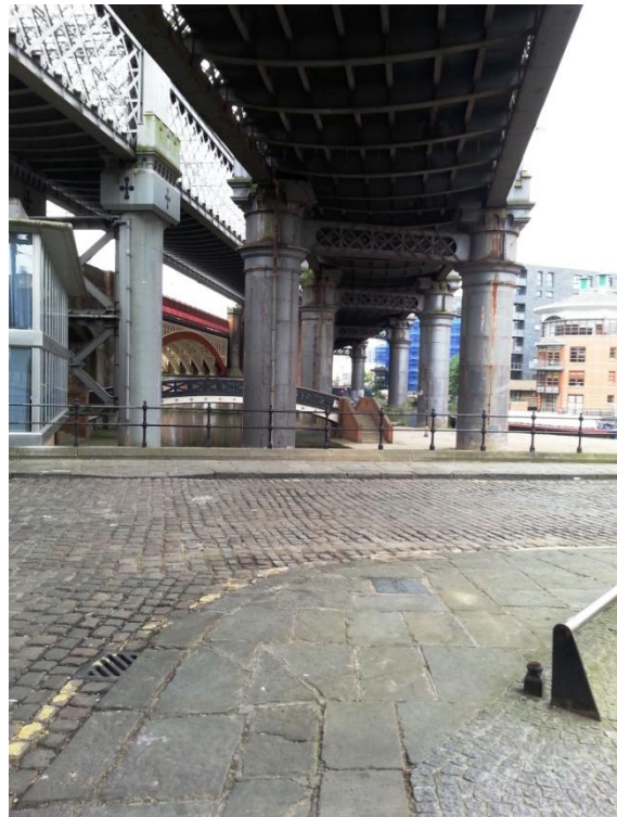
gietijzer constructie spoorlijnen
